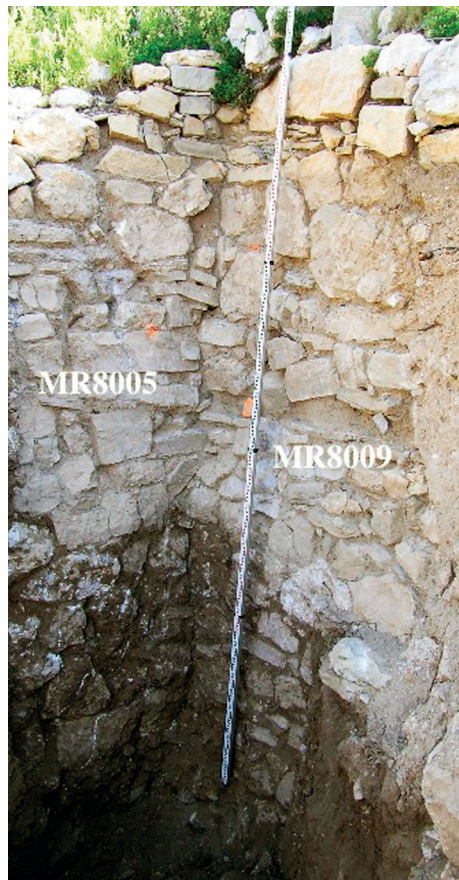
Fig. 73. Le parement extérieur du rempart MR8009, conservé sur plus de 4 mètres de hauteur. Vue SO-NE.
