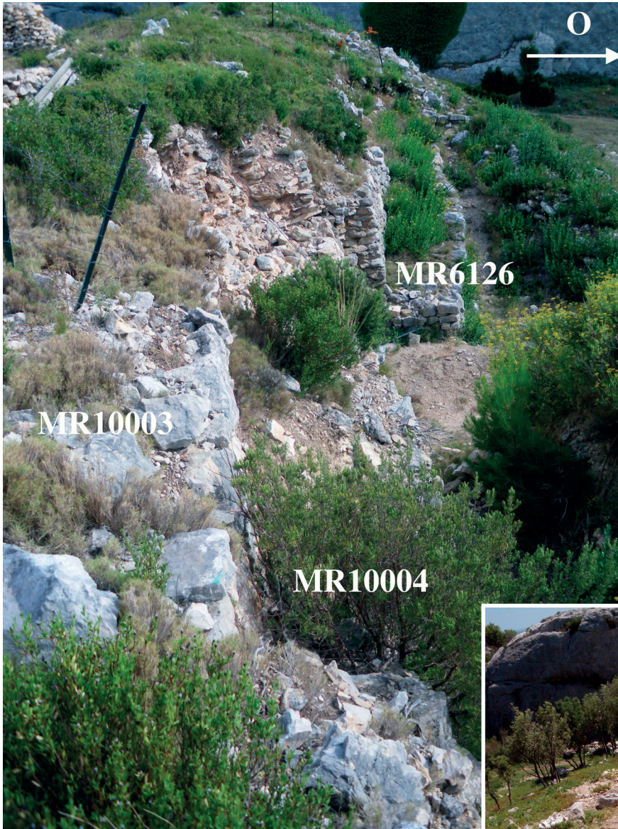
Fig. 70. Parements successifs du rempart R1 visibles de part et d'autre de la zone Z06. Vue nord-sud.
