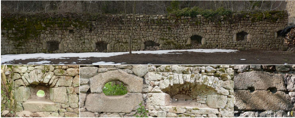
Fig. 3 – Mur ouest et ses six meurtrières, canonniers extérieur et intérieur, meurtrière orientée extérieur et intérieur
