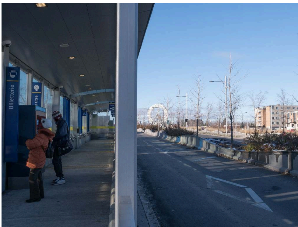
Vue des infrastructures du Service rapide par bus (SRB) sur le boulevard Pie-IX Photo : Denise Caron
