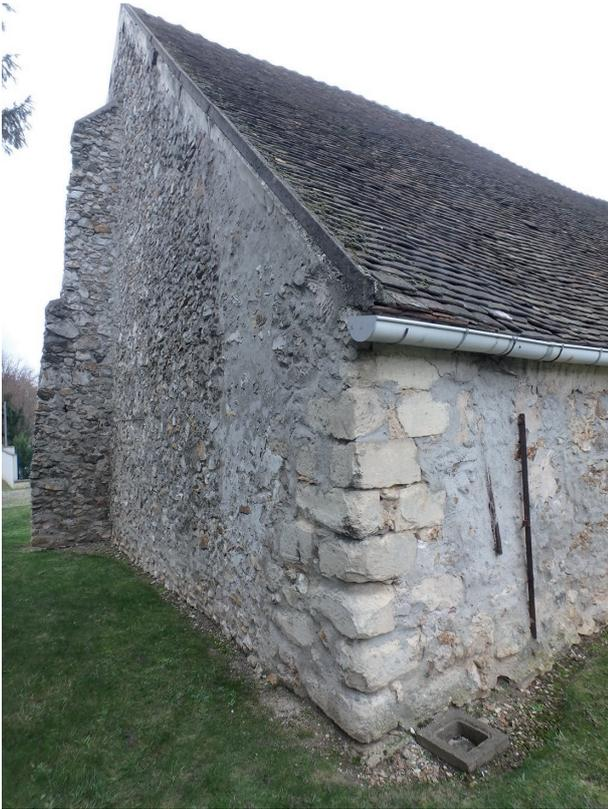
Fig. 18 - Vue du chaînage d'angle nord de la grange, et du contrefort déporté appuyé sur le mur pignon nord-est, à Athis-Mons (Essonne) (© Cliché : J.-Y. Dufour, Inrap).
