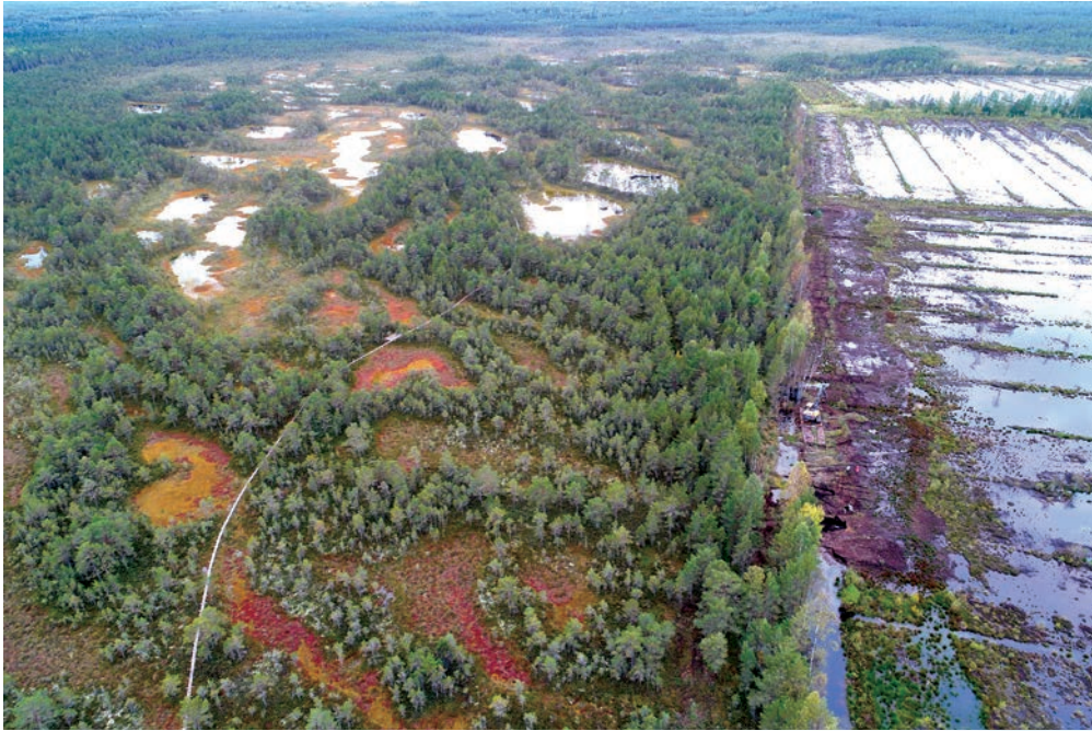
Photo 8a et 8b : Zone de restauration de Viru dans l'ancienne tourbière coupée, près d'un marécage naturel du nord de l'Estonie. Les activités de restauration s'y sont déroulées de 2011 à 2013. Même avec des inondations saisonnières, la région s'assèche tout de même pendant l'été (Photos : Martin Küttim et Raimo Pajula).
