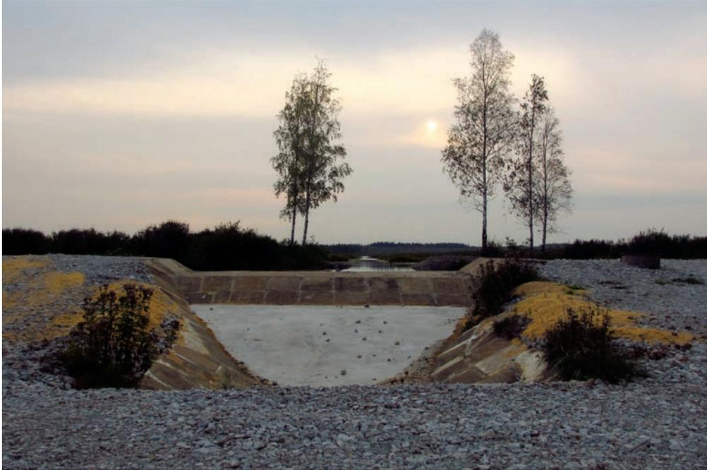
Figure 19 : Barrage sur la rive sud-est du lac Konsu, utilisé pour la régulation du niveau du lac (photo de Marko Vainu).
