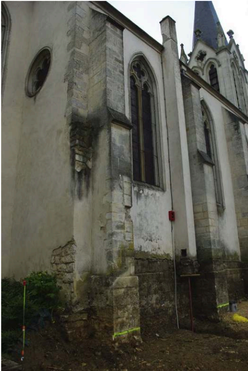
Fig. 2 – Vestiges vraisemblables du mur de l'église médiévale constitué de petits moellons irréguliers (parties décrépées) observables sous le chaînage d'angle du bas-côté
