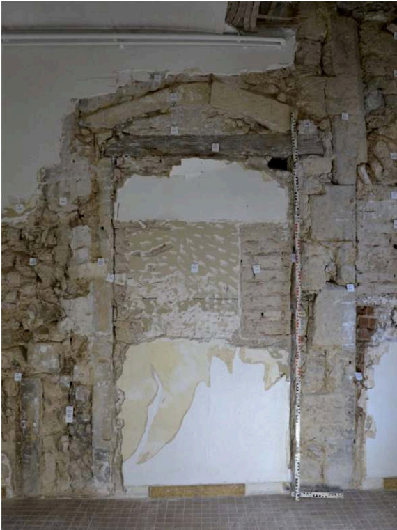
Fig. 1 – Vue de l'élévation 3000, rez-de-chaussée, sd 1, porte 3030, vue d'ensemble
