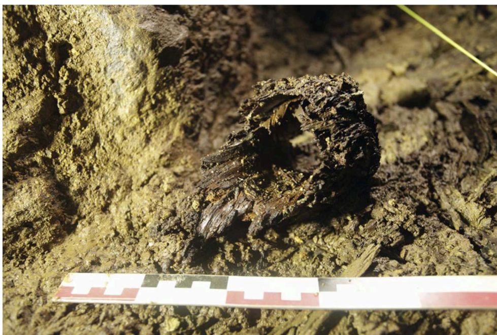
Fig. 1 – Raccord de tuyau dans la galerie nord du niveau 610 m
