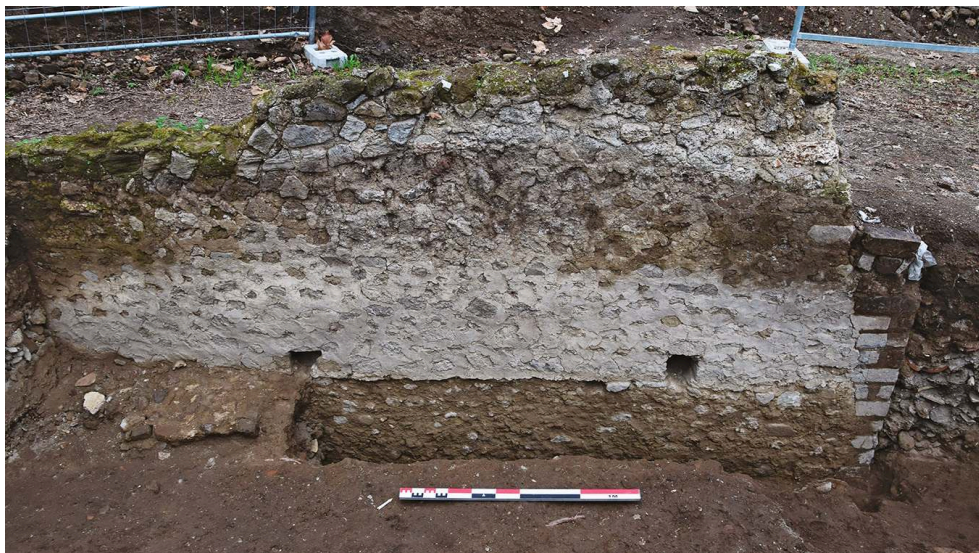
Fig. 8. Le mur MR30003 et sa tranchée de fondation TR20021, vus du sud.
