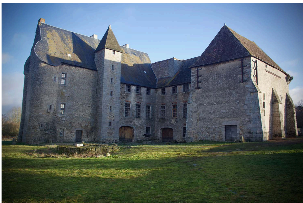
Fig. 1 – Vue de la commanderie depuis le nord-ouest
