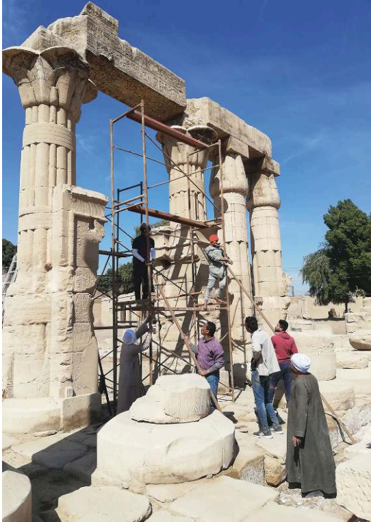
Fig. 5. Préparatifs pour la restauration du portique (F. Relats Montserrat).
