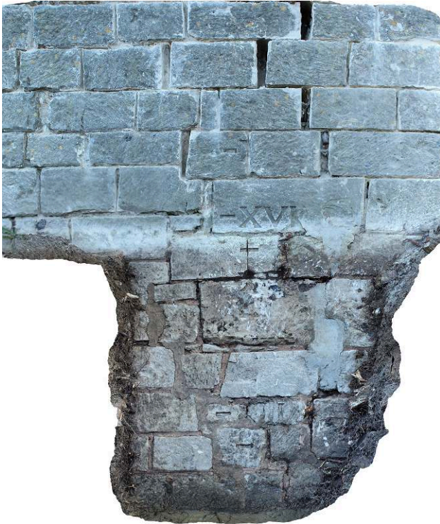
Fig. 2 – Photogrammétrie du mur de quai faisant partie de l'enceinte sud des Tourelles
