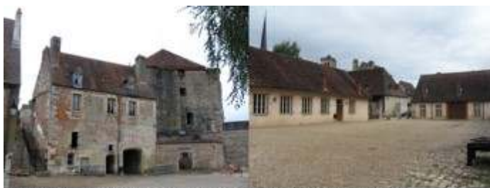
Figure 7 : Mise en patrimoine et reconversion du château Louis XI et de l'arsenal à Auxonne Sources : E.Chiffre 2008
