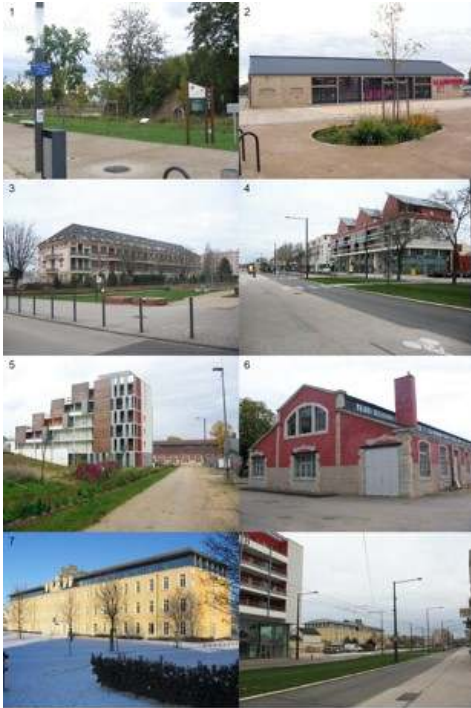
Figure 8 : La requalification des espaces militaires à Dijon : le parc (1) avec les poudrinières et l'ancienne Halle « Bonnotte » (2) du futur écoquartier de l' Arsenal, le quartier Junot (3 et 4), l'écoquartier Heudelet 26 (5 et 6) et le siège de la Communauté Urbaine du Grand Dijon sur l'axe requalifié du tramway (7 et 8). Sources : E. Chiffre, 2010, 2016
