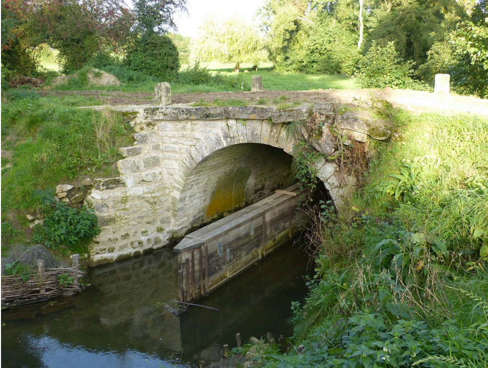
Fig. 1 – Vue du pont depuis l'amont
