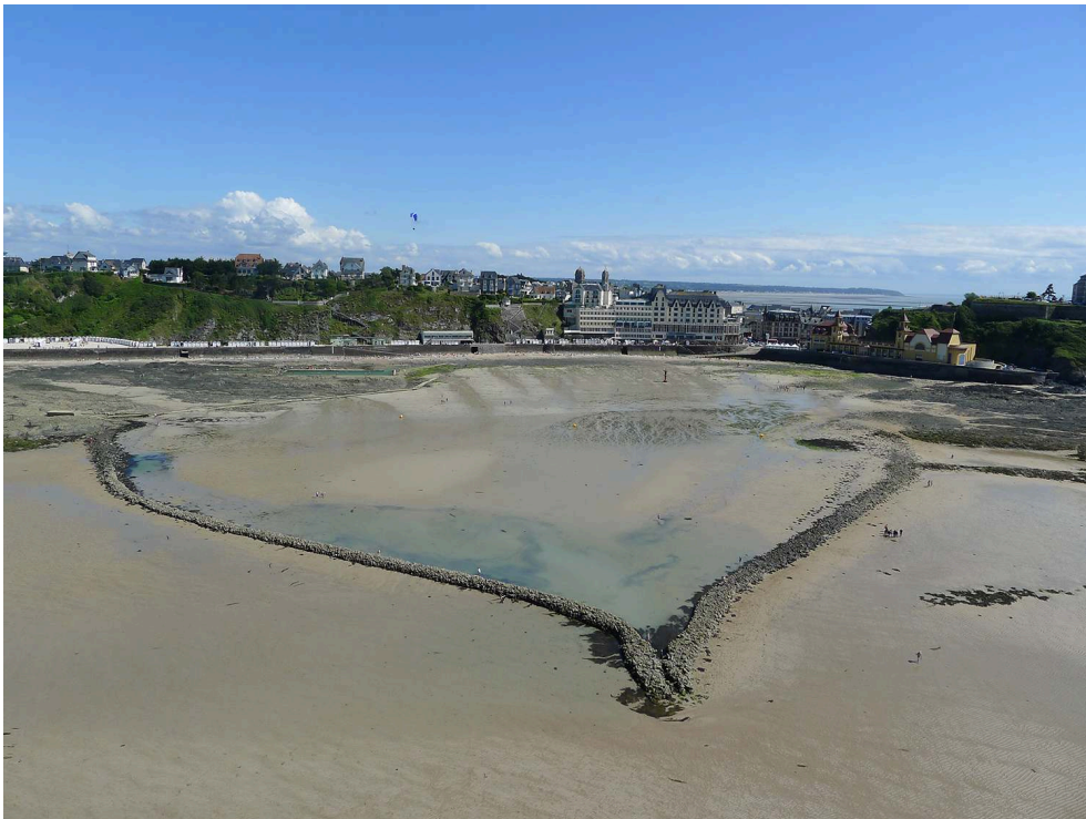
Fig. 2 – Vue aérienne de la pêcherie Cavey avant restauration
