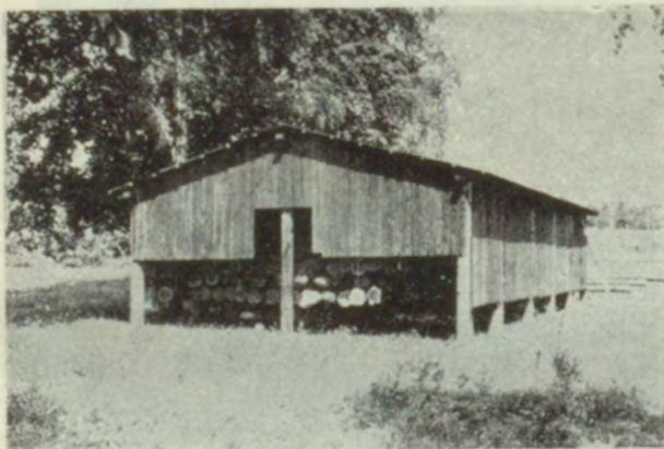
Abb. 8. Trocknen der Holzstangen.
