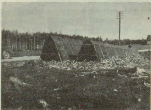
Abb. 10. Konservieren der Stangen nach Osroseverfahren.
