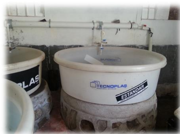
Foto 3. Mejora en la instalación hidráulica
