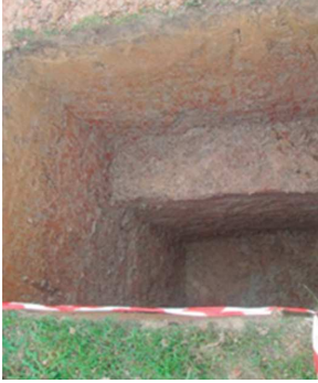
Calicata central culminada 2 x 1 m de profundidad.
