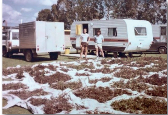
Figura 5. Lonas contendo os frutos lenhosos de eucalipto, expostas ao sol, para secagem e extração de sementes.
