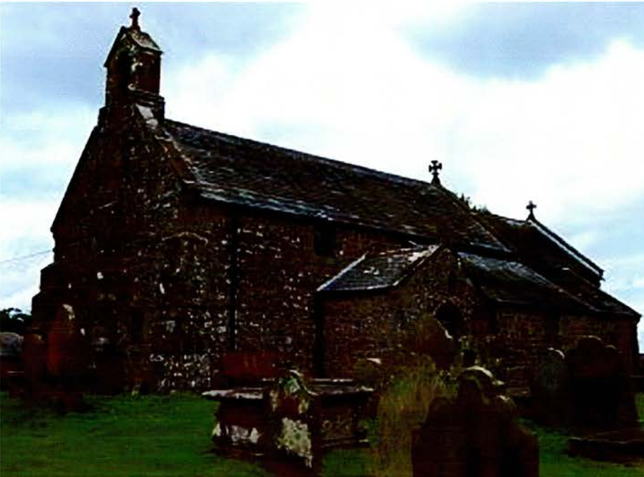
65) Cross Canonby (St John) : general view
