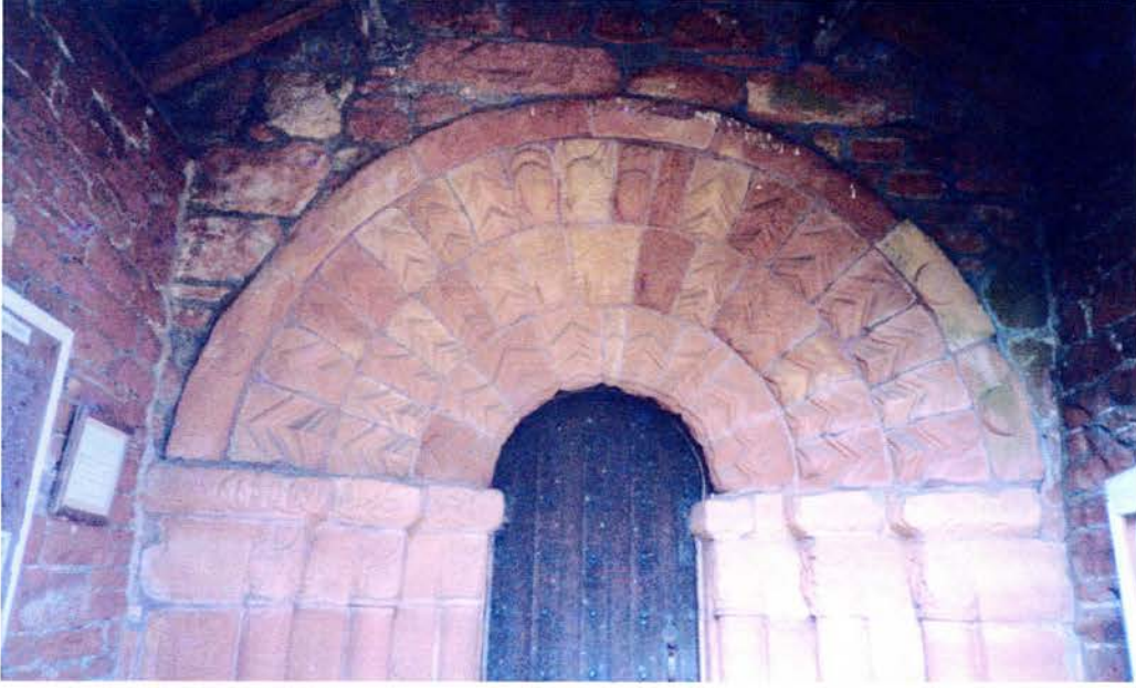
78) Great Salkeld (St Cuthbert) : south doorway
