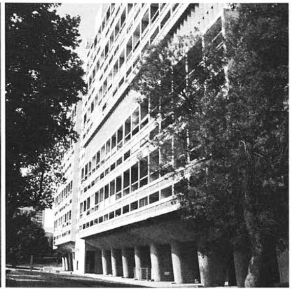
Figure 3.27: Unité d'habitation, Marseilles
