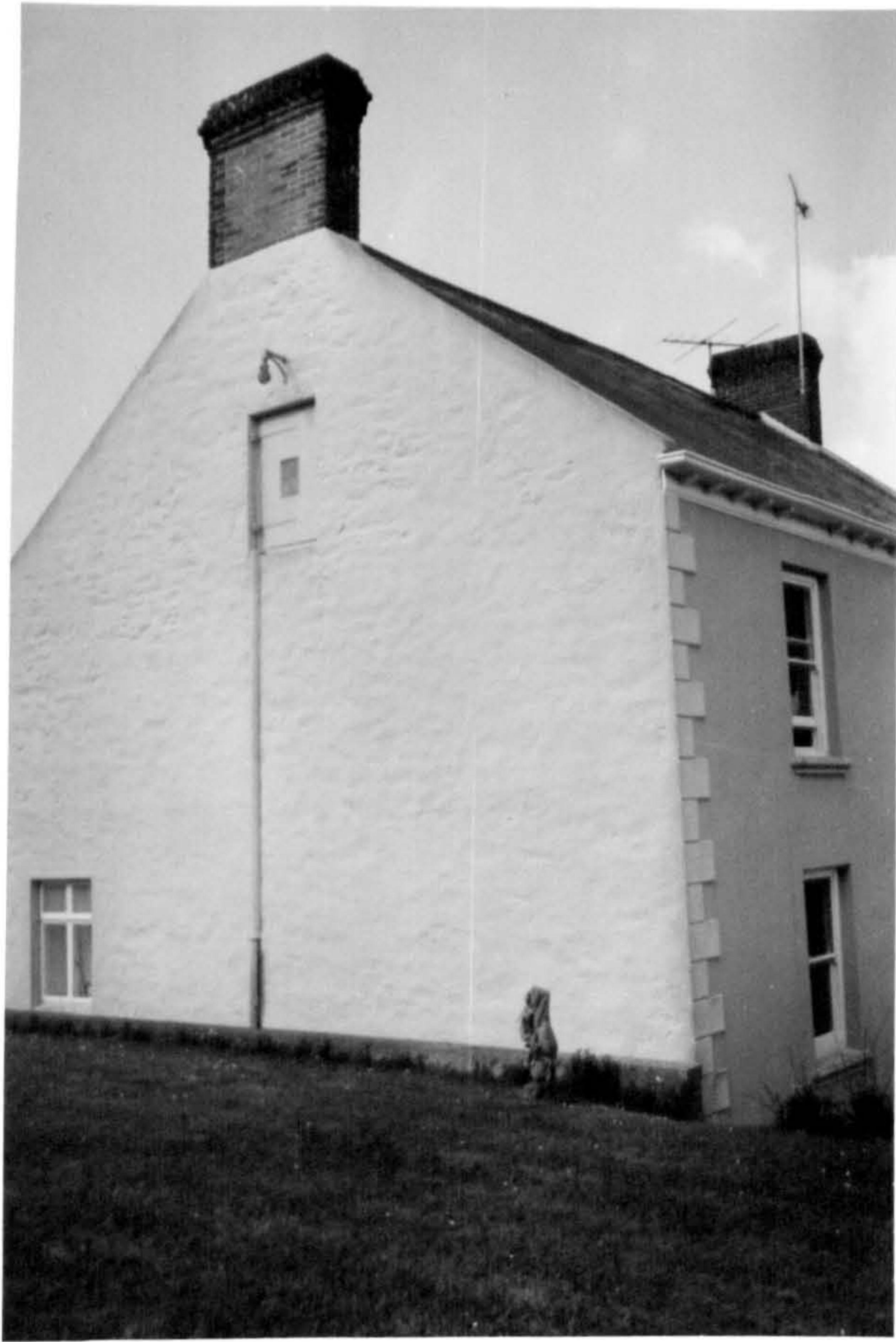
/la djèrbyèr/ la trappe qui donne accès au grenier
