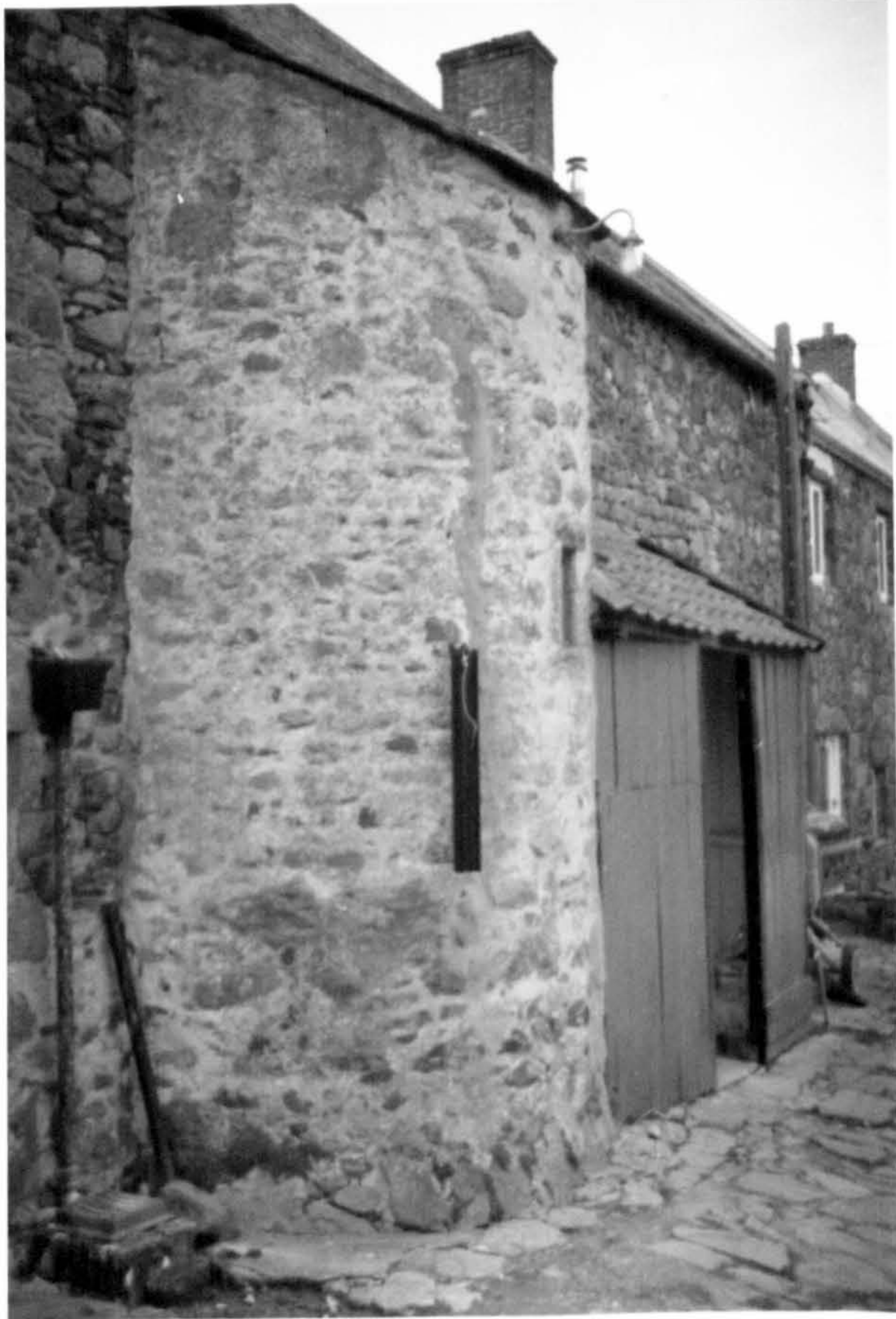
la tourelle de l'escalier
