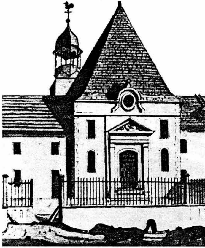
Fig.3 Chapel of the Récollet Convent, begun 1706, Pierre Janson dit Lapalme
