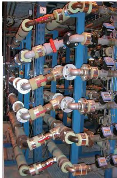
Figure 76: Partie fluidique (canalisation) du pilote REI.
