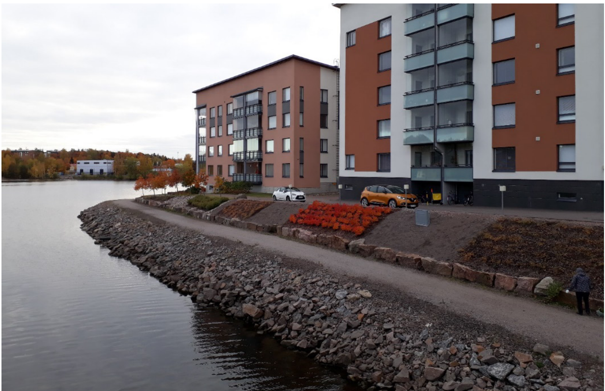
Kuva 11. Jalankulkukaupunkimaisen tiiviiksi rakentunutta Pikisaarta kiertää Lappeenrannan rantaraitti. (Nyberg, 2019.)
