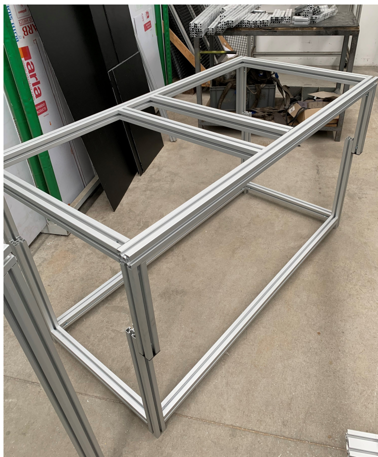
Figura D.1: Montagem da base e da estrutura central.
