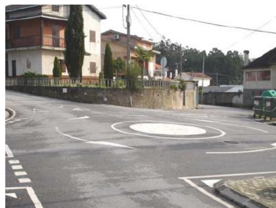
Figura 28. Mini-rotunda, marcada no pavimento (Cantanhede) (Rodrigues, 2010).
