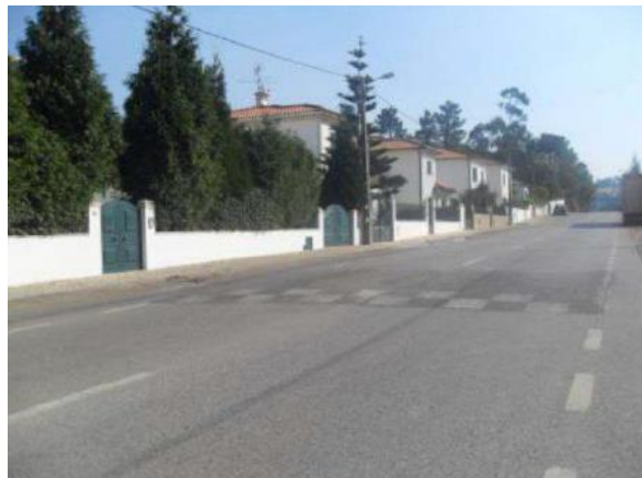
Figura 34. Exemplo de uma lomba redutora de velocidade, numa zona residencial (Coimbra) (InIR).
