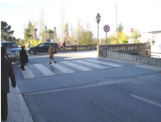
Figura 37. Exemplo de uma interseção elevada (Tomar). (Rodrigues, 2010)
