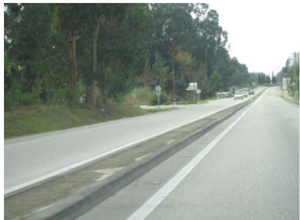
Figura 24. Exemplo de um separador central (EN 234) (Rodrigues, 2010).
