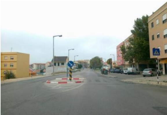
Figura 32. Exemplo de um estrangulamento pelo centro (Pereira, 2013).
