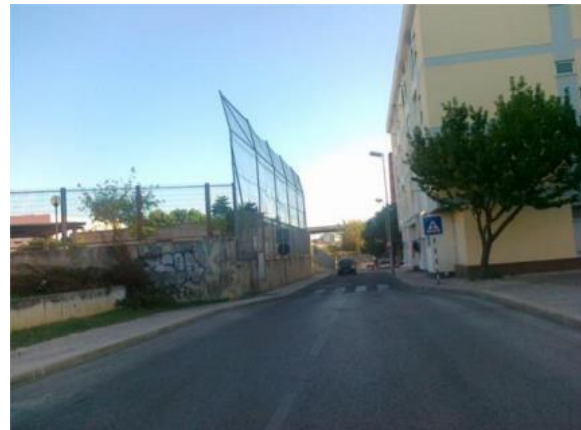
Figura 31. Exemplo de um estrangulamento pelo lado (Pereira, 2013).
