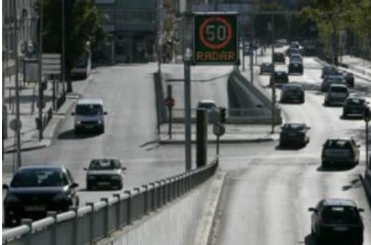
Figura 39. Exemplo de um radar de controlo de velocidade. (Pereira, 2013)
