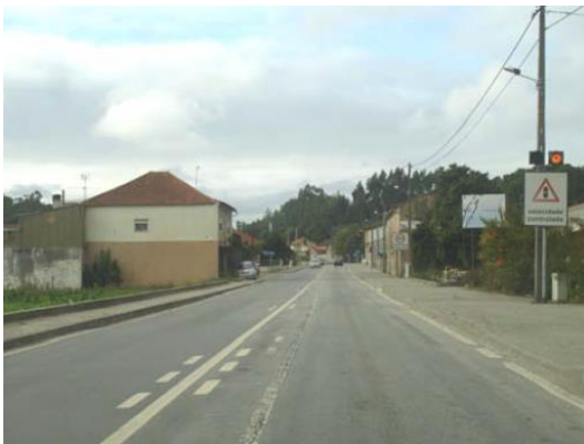
Figura 41. Sinal de pré-aviso de semáforo (Cantanhede). (Rodrigues, 2010)
