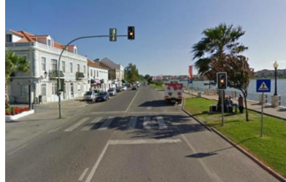
Figura 40. Exemplo de um semáforo de controlo de velocidade. (Pereira, 2013)
