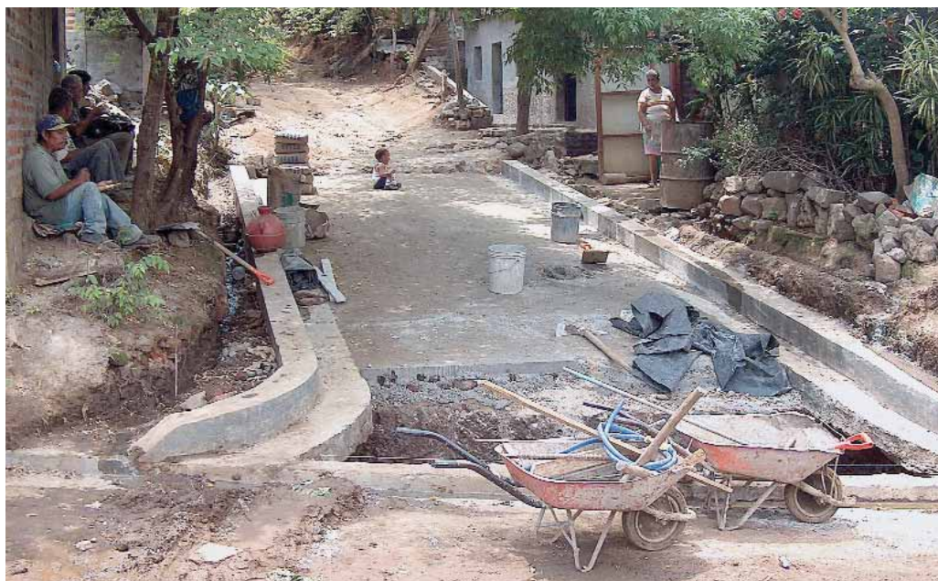
Proyecto de infraestructura vial.
