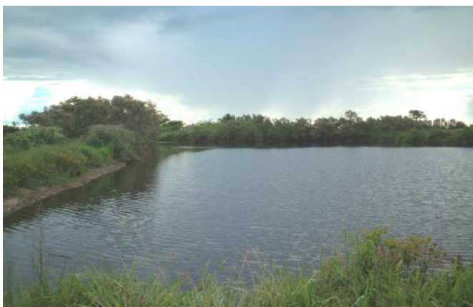
Figura 5. Lagunas de oxidación para el tratamiento de aguas residuales. Fuente: cortesía Ingenio Azucarero Roberto Barbery Paz -UNAGRO
