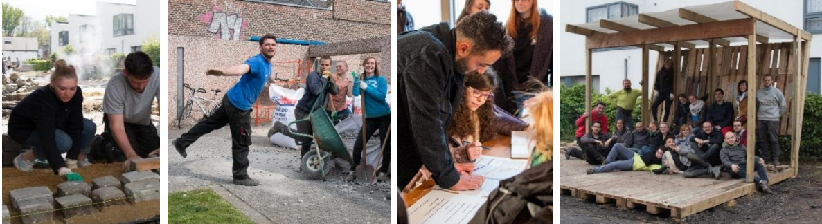
2017-2018 – Habitat-Service asbl : cour collective et espaces de travail social
