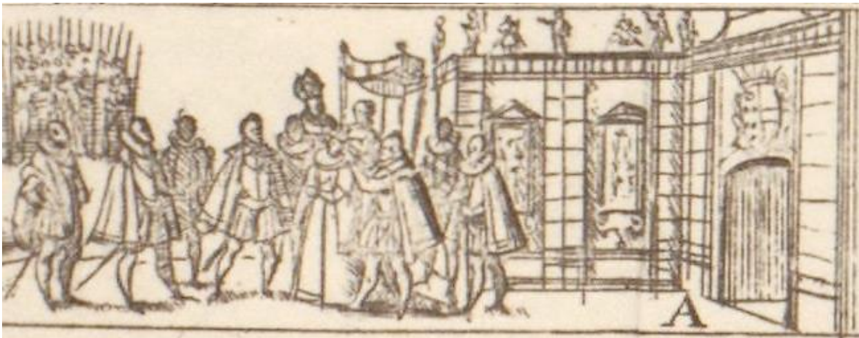
Fig. 1. 7 Particolare della figura 1. 3: L'arco trionfale alla Porta al Prato
