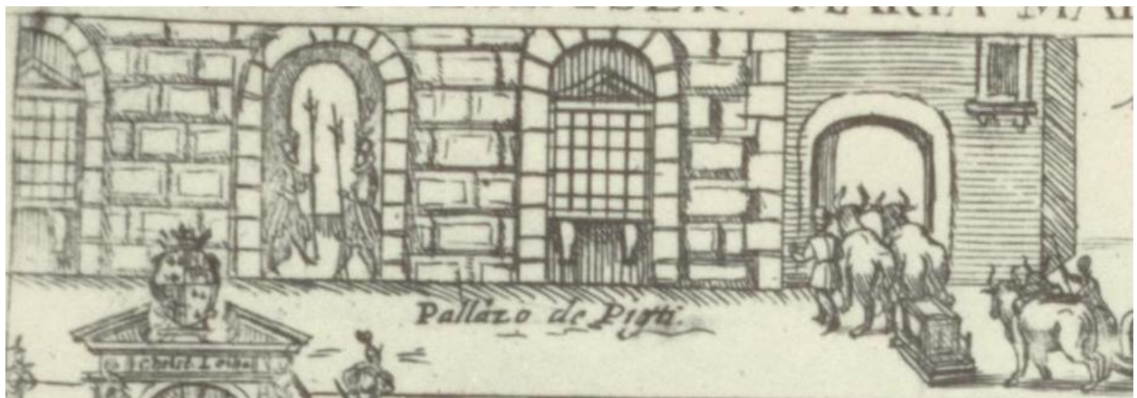
Fig. 1. 23 Particolare della fig. 1.3: Il Palazzo Pitti
