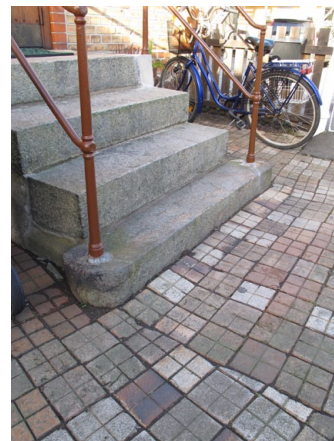
Bild 27: Trappan i granit med ledstänger i järn.
