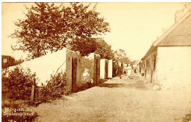
Bild 1: Arbetarbostäderna Sjölängorna med tillhörande uthus och odlingar. Sjölängorna var några av de första arbetarbostäderna som uppfördes, 1797-98.
