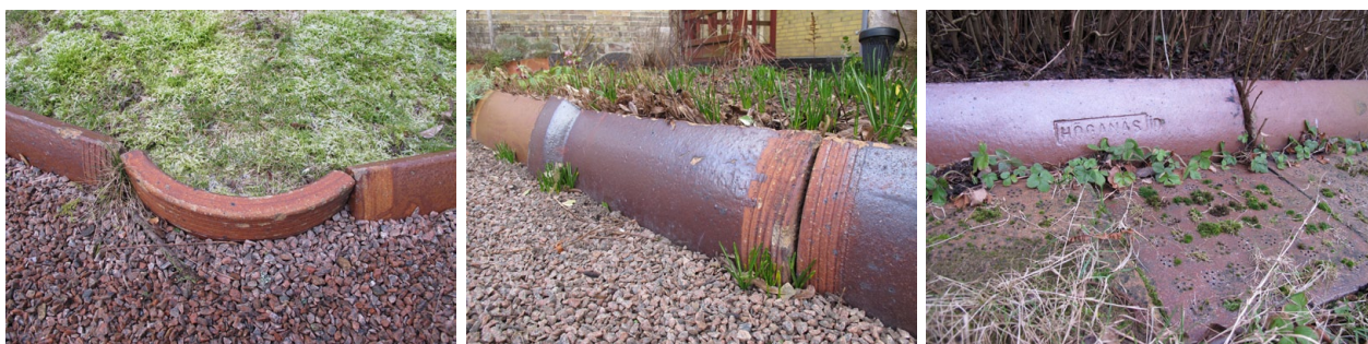
Bild 40, 42, 42: Saltglaserade avloppsrör som delats används ofta som kantstöd i rabatterna, både stående och liggande. Smedjegatan, Tivoligatan.
