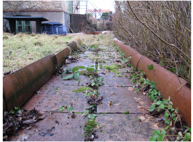
Bild 18: Gången belagd med keramiska siltegelplattor och kantas av halverade avloppsrör löper utmed syrenhäcken mot brunnen i trädgårdens sydöstra hörn.
