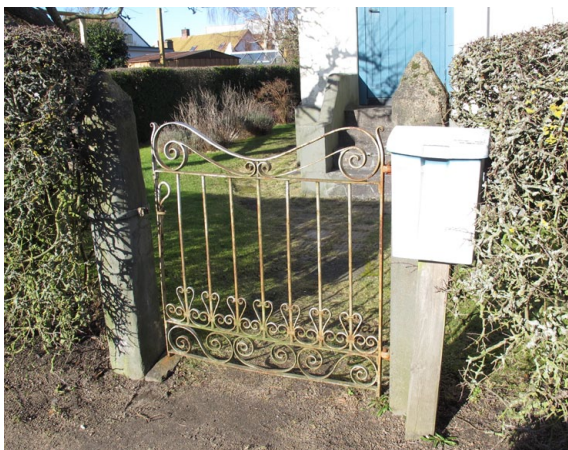
Bild 46: Många järngrindar av den här typen hänger på grindstolpar av granit i Tivolivången.
