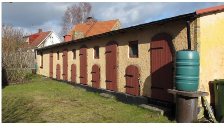
Bild 7: Uthuslänga till flerfamiljsvilla på Långgatan. Ursprungligen var uthusen avsedda för kolförråd, höns och dass. Längan ligger på tomtgränsen och på dess baksida ligger en likadan som är vänd mot grannfastigheten.
