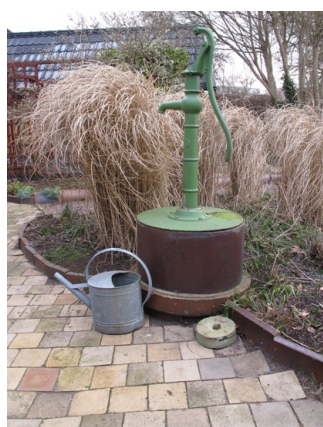
Bild 49: Brunn av stort keramiskt avloppsrör med pump av gjutjärn ovanpå. Fortfarande i bruk vid bevattning. Smedjegatan.
