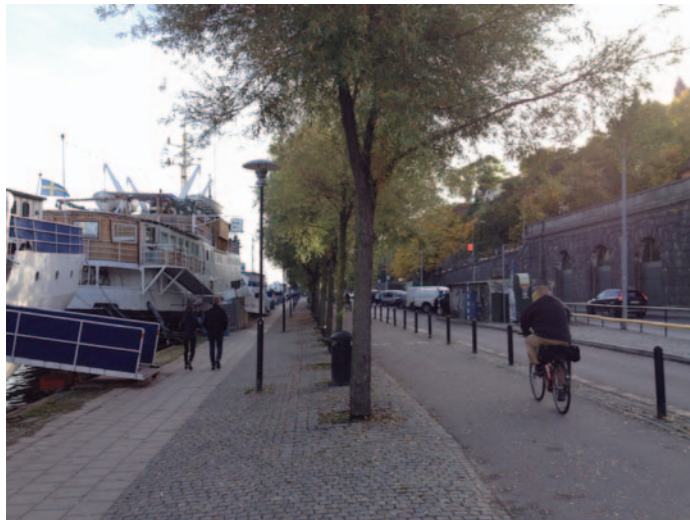
Bild 29: Cykelbanan en fil i vardera riktning. Totalt är den 2 m. bred och sträcker sig längs med hela Söder Mälarstrand. Skyddas av ett räcke mot trafikleden.
