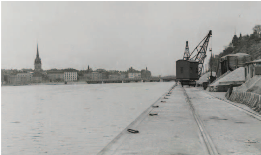
Bild 11: Utsikt mot Gamla stan och järnvägsbron vid söderström. Kajen är utrustad med spår för lyftkranar. Branta trappor länkade samman stranden med bebyggelsen på Södermalms klippor. Fotot är från 1954. Foto: Stockholms Hamnar
