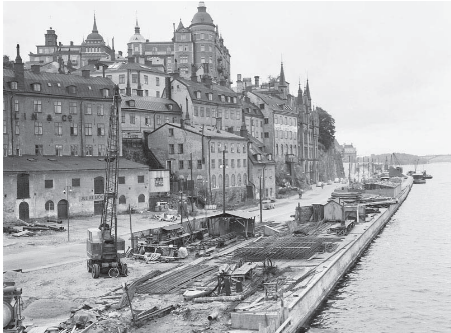
Bild 9: Utsikt mot Söder Mälardockan från Centralbron vid Söderström. Området har utvecklats till ett hamnområde. Fotot är från 1955. Foto: Jan Ehnemark
