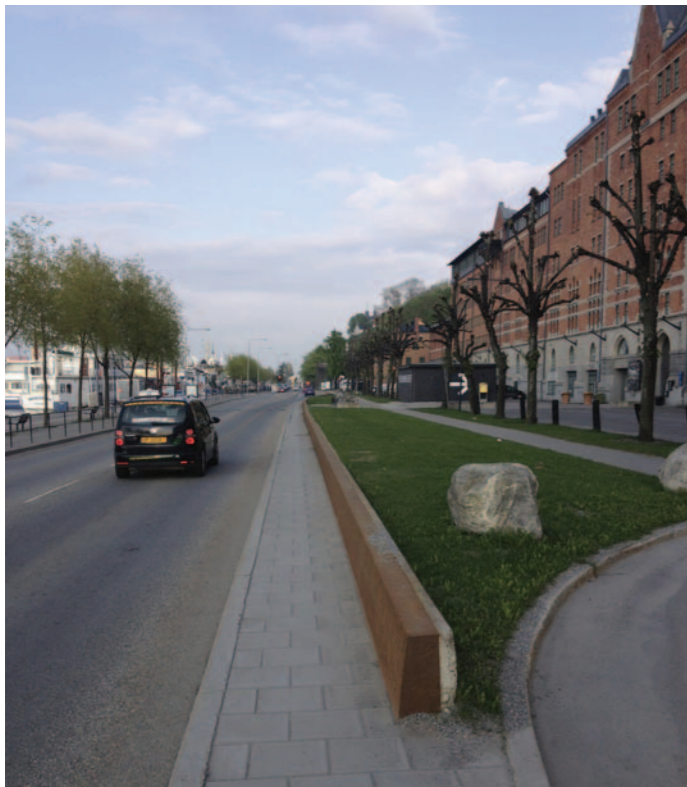
Bild 32: Formklippta Lindar utanför Münchenbryggeriet. Gräsytan ger en känsla av halvprivat karaktär. Foto: Peter Staflin
