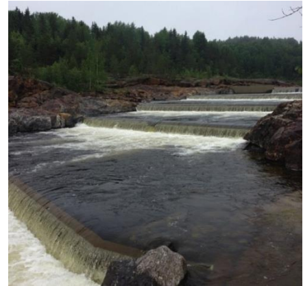
Figur 7. Till vänster, i vänster bild, ses övre delen av Kungsmofallet, sett ovanifrån innan ombyggnation. Till höger ses de gjutna betongstegen efter ombyggnationen som var klara till vandringsäsongen 2012.
