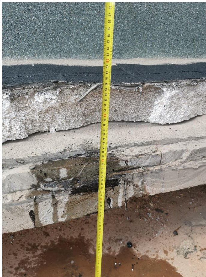
Obr. 89: Zjišťování vrstvy násypu, 260 mm - fotografie
