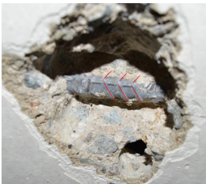
Obr. 86: Zjišťování výztuže v soustavě PS61 v Krejčíkově ulici – fotografie
