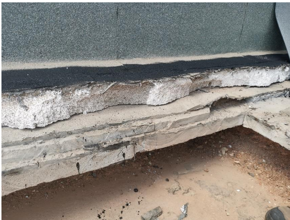
Obr. 88: Detail prováděné sondy - fotografie
