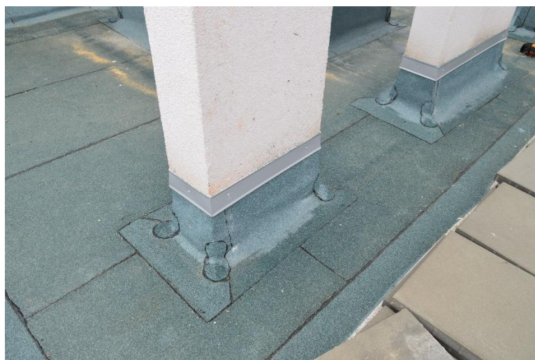
Obr. 95: Detail položení hydroizolační vrstvy - fotografie
