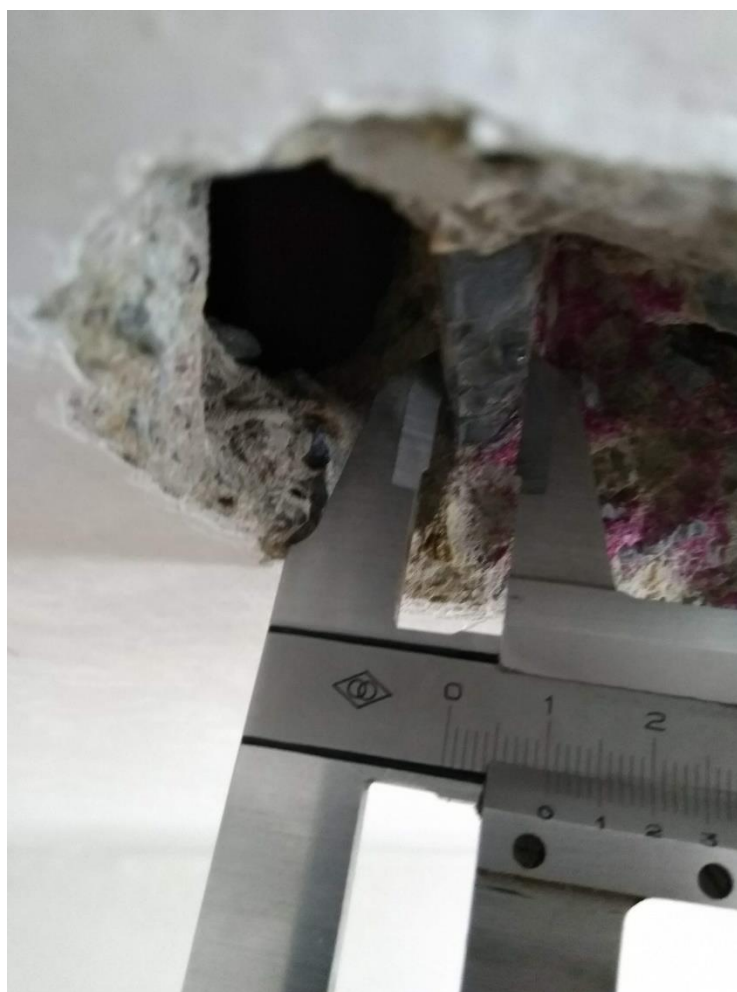
Obr. 100: Zjištění profilu výztuže, profil 10 - fotografie
