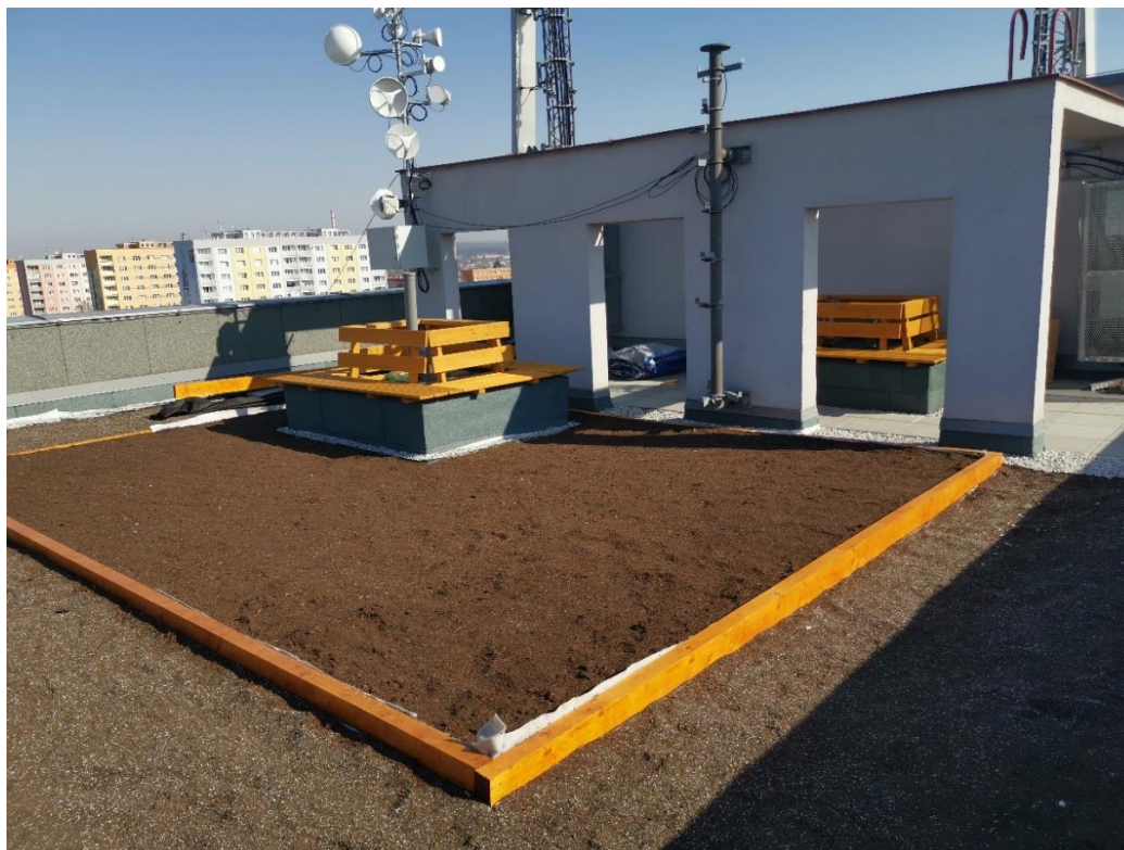
Obr. 102: Nový stav vegetační střechy – fotografie 1
