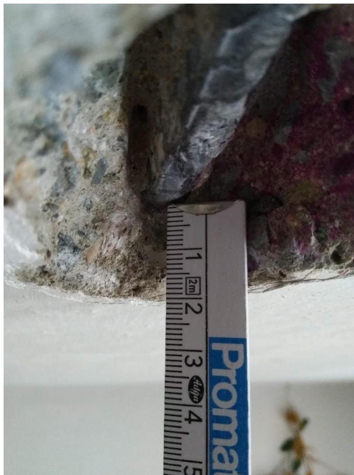
Obr. 101: Zjišťování krycí vrstvy, 20 mm – fotografie
