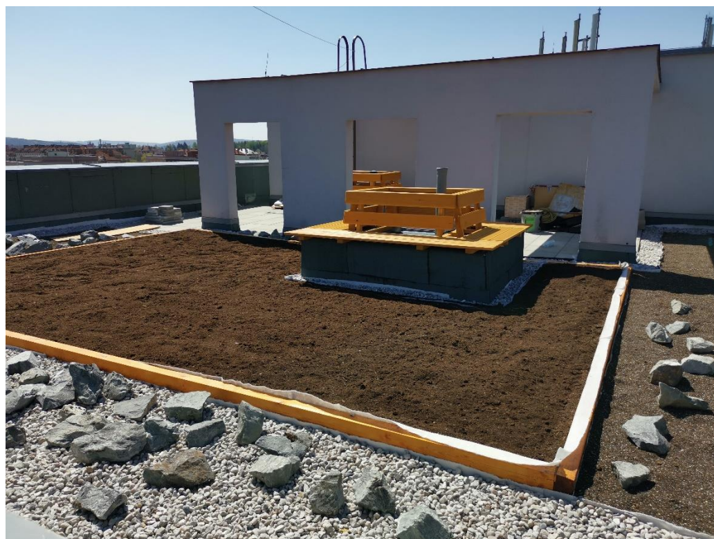
Obr. 103: Nový stav vegetační střechy – fotografie 2
