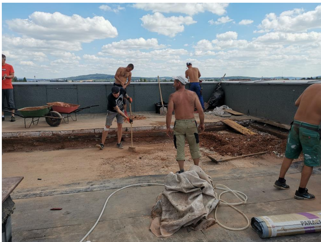
Obr. 92: Odstraňování původní skladby - fotografie
