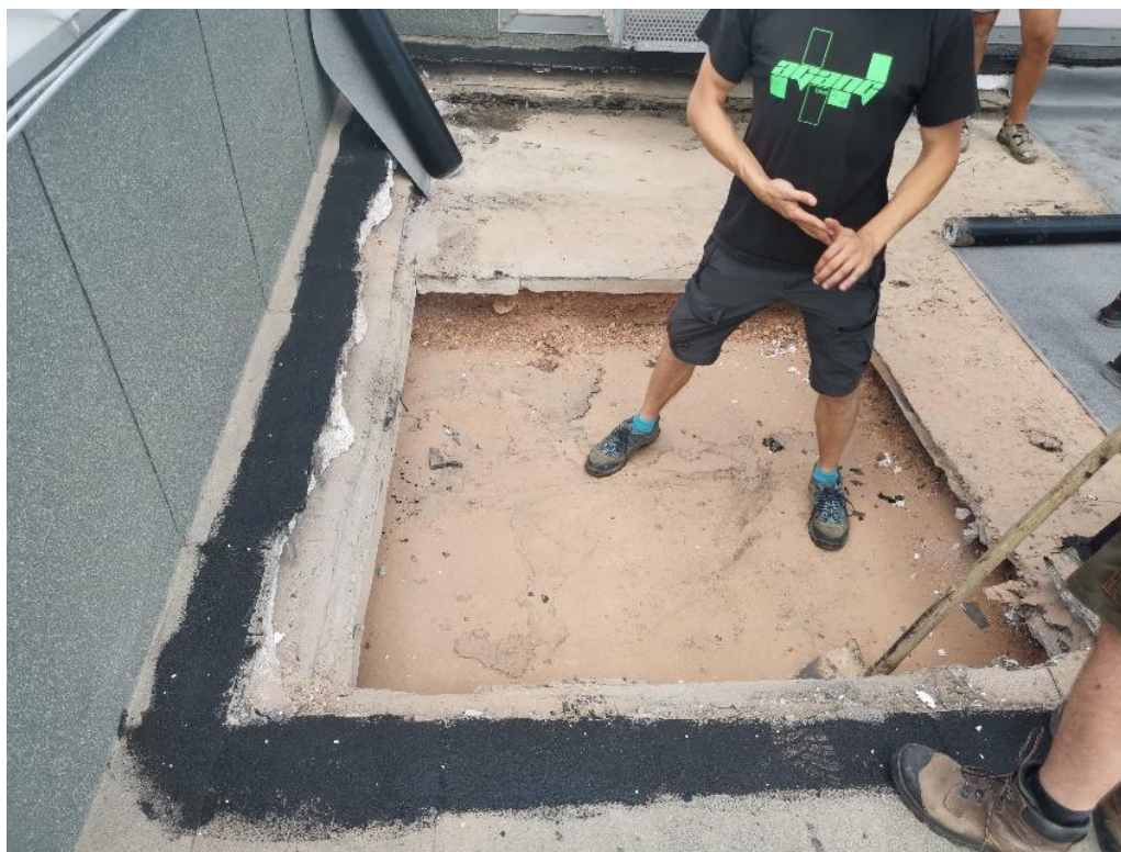
Obr. 87: Provádění sond skutečného stavu - fotografie
