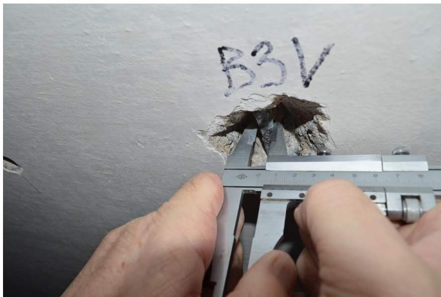
Obr. 99: Zjišťování výztuže - fotografie
