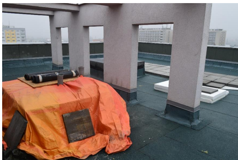
Obr. 94: Položení hydroizolační vrstvy – fotografie 2
