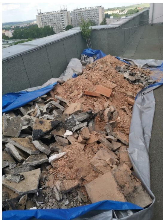
Obr. 90: Odstranění původní skladby - fotografie
