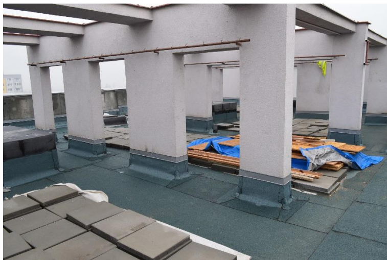
Obr. 93: Položení hydroizolační vrstvy – fotografie 1
