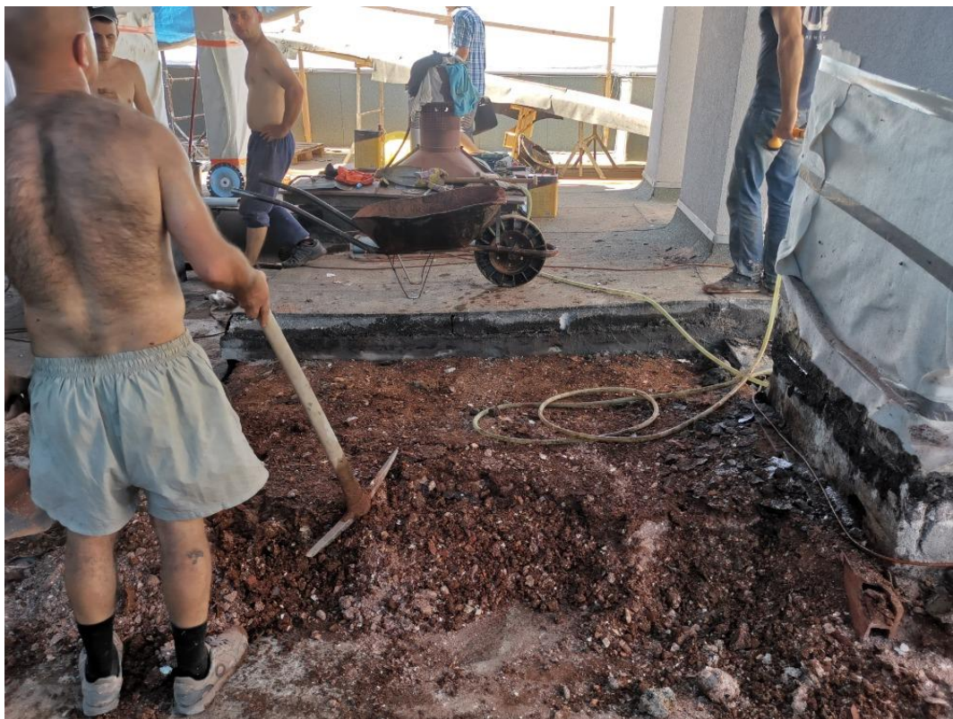
Obr. 91: Rekonstrukce střešní konstrukce - fotografie
