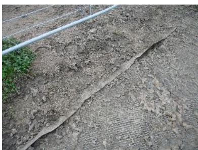
Bild 12: Visar fålla 13 där geotextilen trampats upp vid grindhålet.
