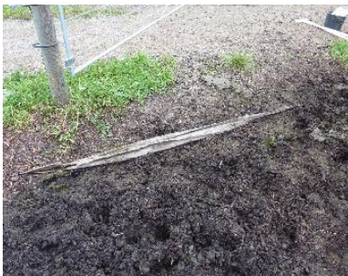
Bild 7: Visar hur geotextilen blivit upptrampad i grindhålet.
