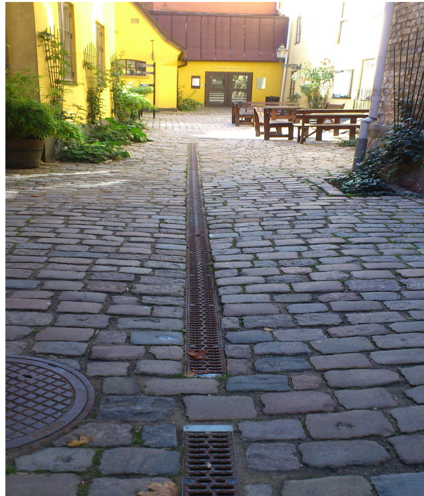
Linjeavvattning i gamla kvarteret Sankt Gertrud i Malmö.
