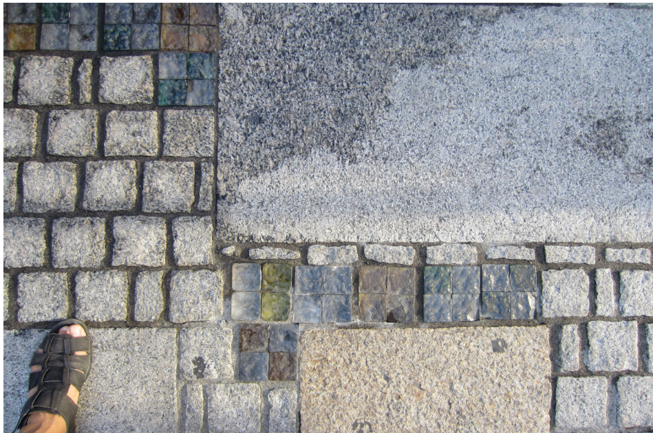
Den berömda gågatan Ichibangai i Kawagoe i Japan är belagd med småsten och små glasblock.
