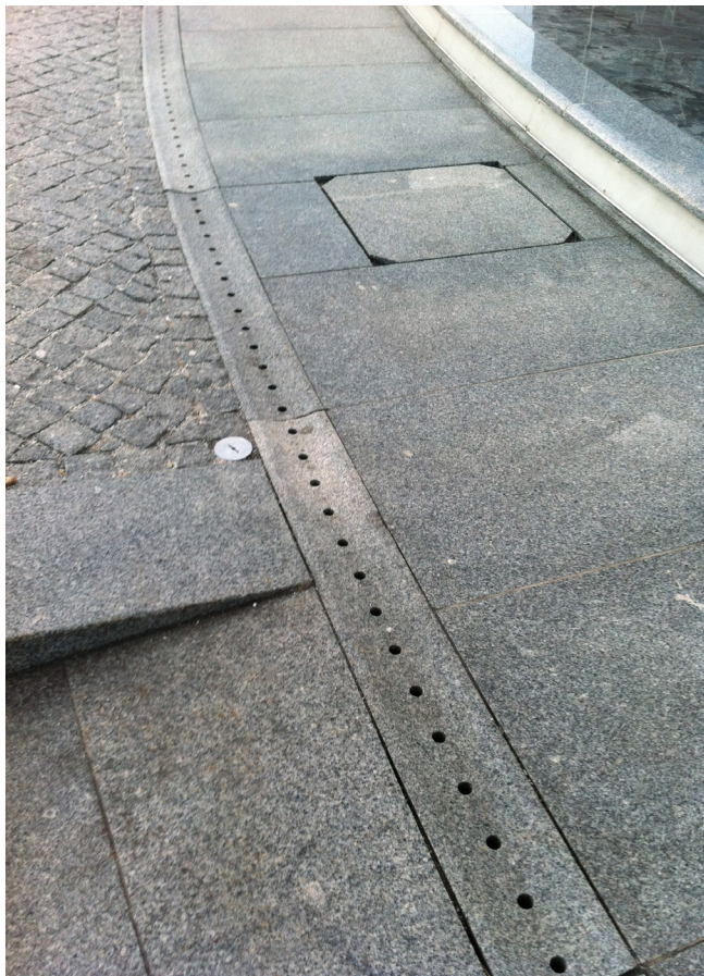
Linjeavvattning på annat sätt: Här är den gjord av granit med hål där vatten kan rinna igenom. Dessutom är den böjd i en båge så att den ska passa i stenläggningen. Exempel från den allmänna platsen precis utanför Turning Torso i Malmö.
