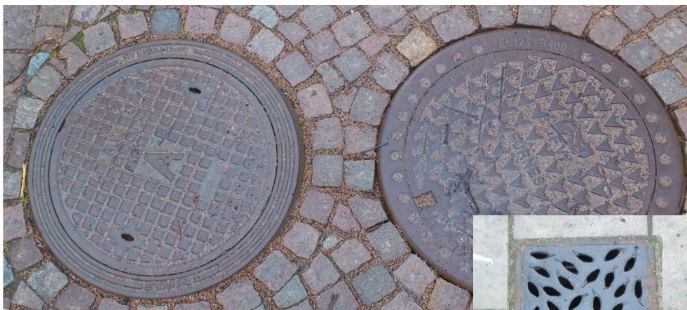
Brunnsbetäckning i Lomma Kommun
