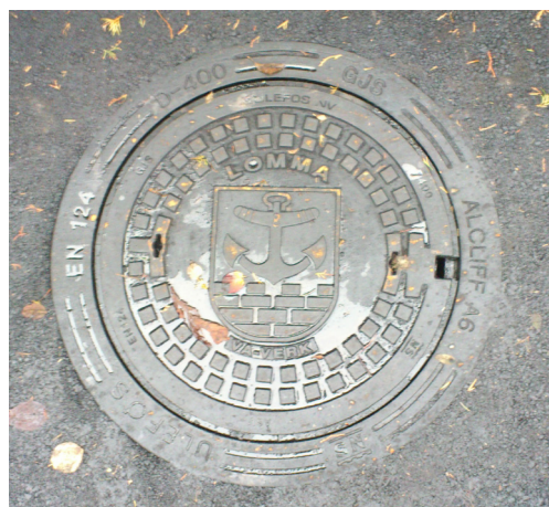
Brunnsbetäckning i Lomma med kommunens vapen
