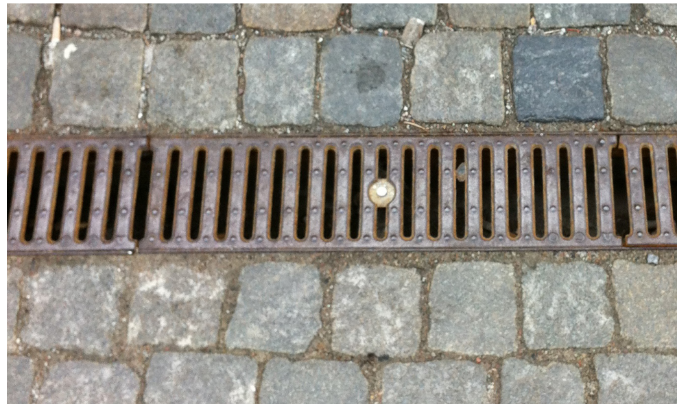
Exempel från Lilla Torg i Malmö. Torget är satt med gammal gatsten med känsla av att vara sliten. Randigt avvattningsgaller i rostigt järn. Färgen smälter bra in, mönstret avviker dock en del från omgivande formspråk.
