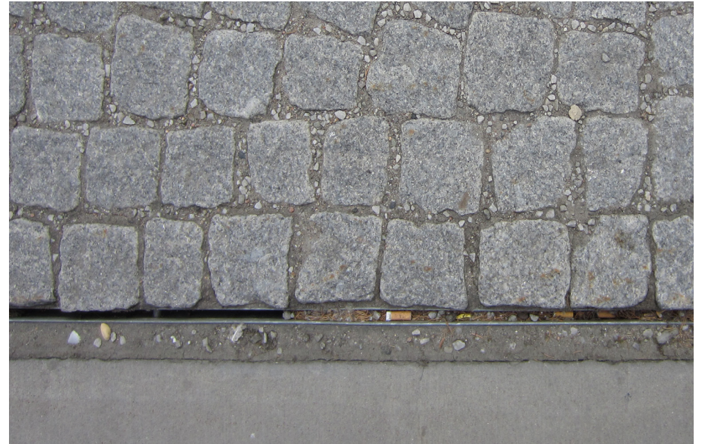
Ibland ställer dock slitsar, som den ovan, till problem. Här har det blivit stopp på grund av grus och fimpar. Exempel från Dockplatsen, Västra Hamnen, Malmö.
