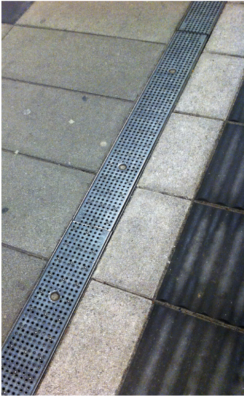
Exempel från Malmö Centralstation. Rutigt avvattningsgaller.
