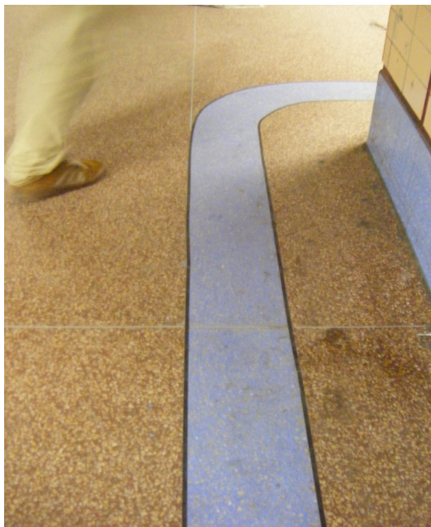
I Stockholms tunnelbana får vi hjälp av symboler i marken för att leda oss rätt.
