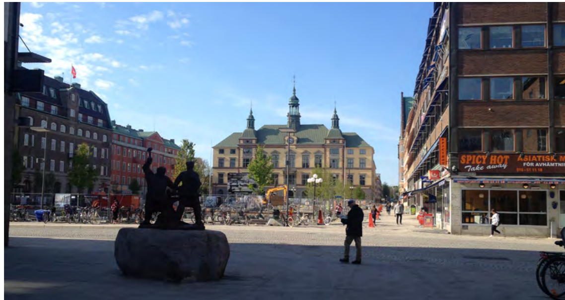
Fristadstorget i Eskilstuna under ombyggnad.
