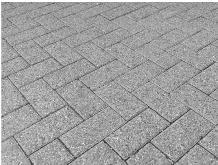
Figur 23: Betongplattor i vinkelförband. Fersens väg, Malmö. (Foto: My Söderberg, 2014)
