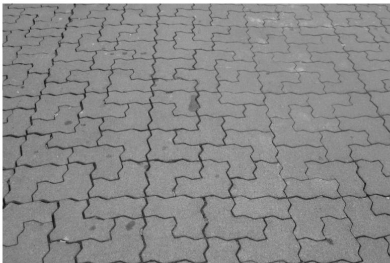
Figur 25: Låsstenar i betong. Värnhemstorget, Malmö. (Foto: Niklas Klingberg, 2010)
