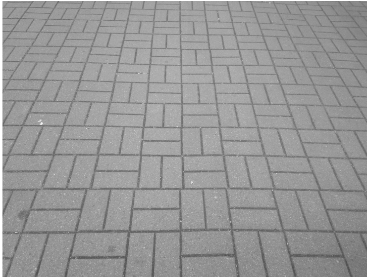
Figur 20: Betongplattor i blockförband. Kungsgatan, Malmö. (Foto: Rebecca Rönnmak, 2014)
