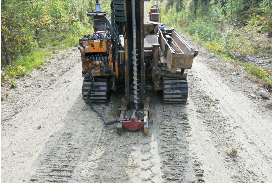
Figur 5. Skruvprovtagare monterad på geoteknisk borrhandsvagn. Foto: Gustav Karlefors.
