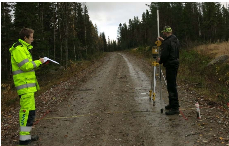
Figur 15. Mätning av körbanans profil med rotationslaser och Z-fix. Foto: Gustav Karlefors Figure 15. Measurement of road surface profile with a rotating laser and Z-fix. Foto: Gustav Karlefors
