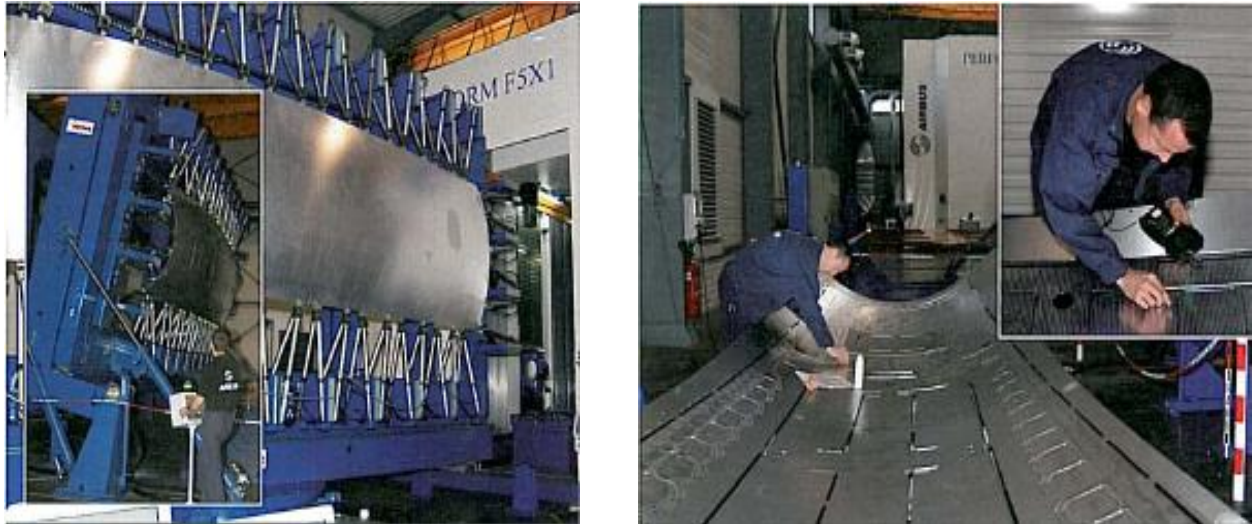
Figura 3.12 - Scarico del pannello e controllo dello spessore.
