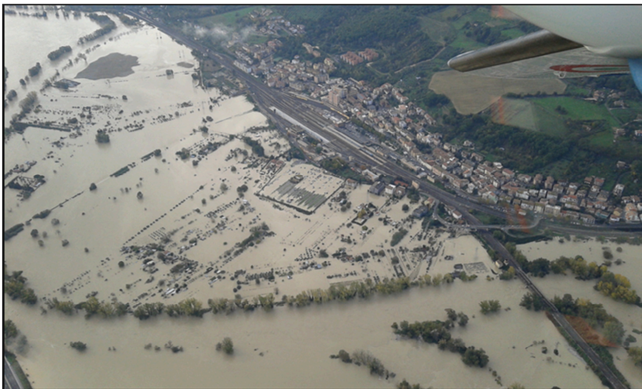
Fig.III Esondazione fiume Tevere ad Orte(VT)-Novembre 2012
