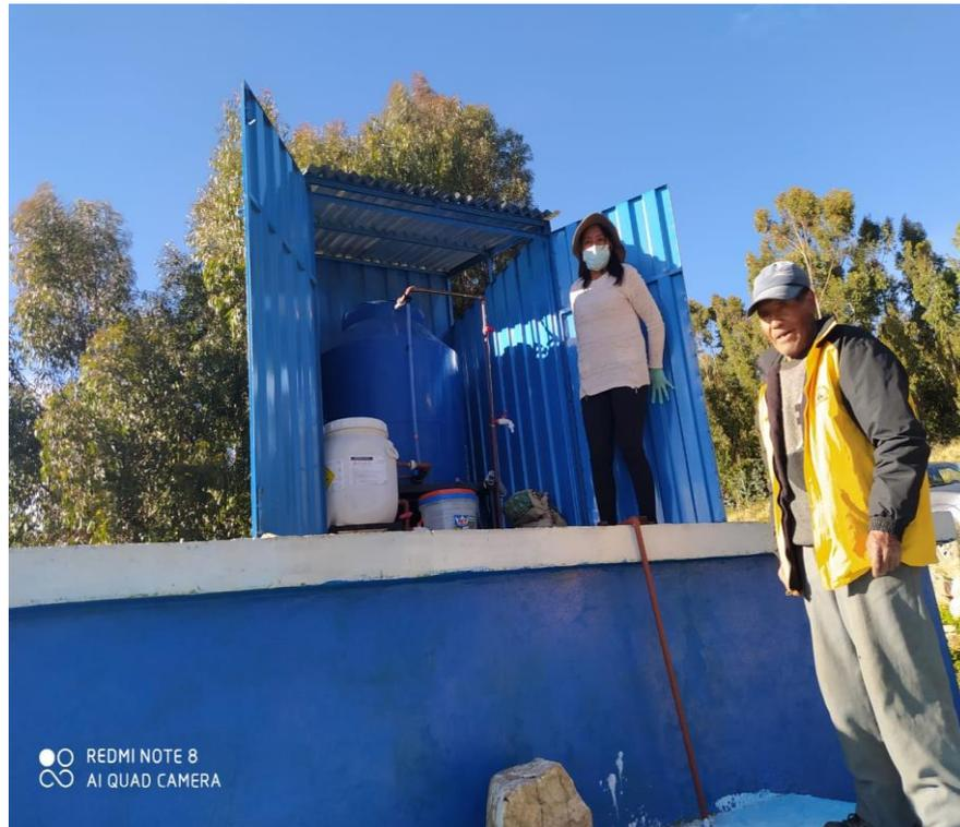
**Fotografía 7.** Verificación del sistema de cloración por goteo en el reservorio
