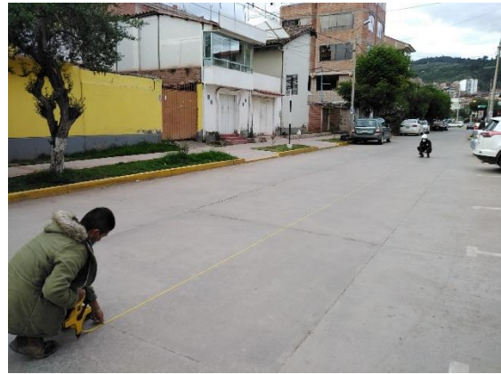
Proceso de medición de vía
