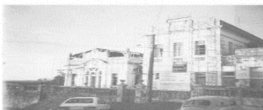
Obras de intervención 1988: "Hotel Globo".
