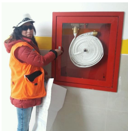
Figura N°15 Conexión de manguera sistema tipo II
