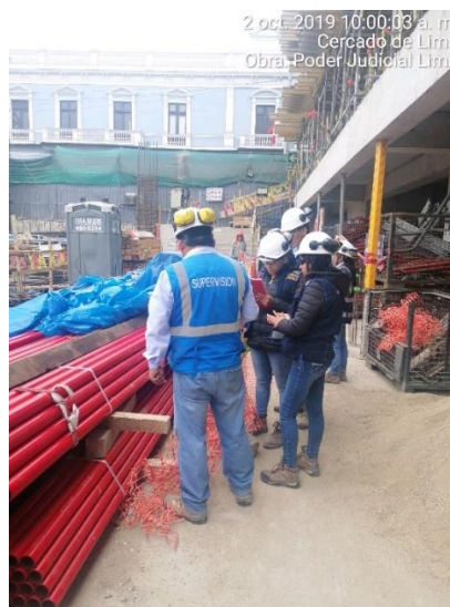
Figura N°05 Verificación en obra de tuberías a instalar
