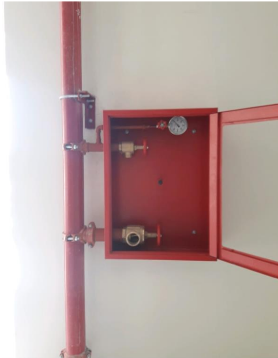
Figura N°10 Instalación de tubería vertical
