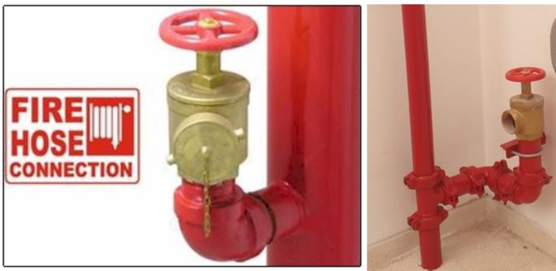
Figura N°14 Conexión de manguera sistema tipo I
