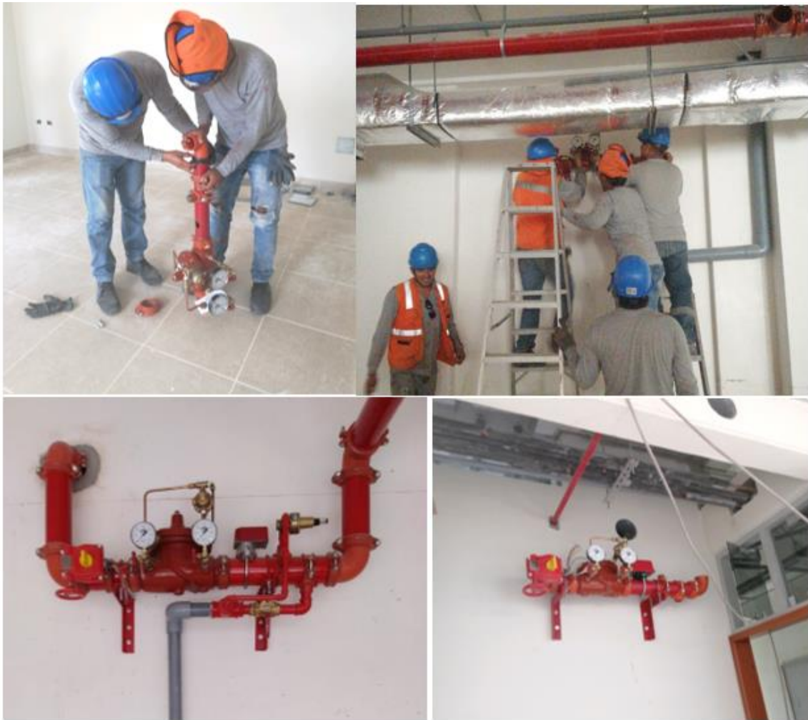
Figura N°20 Instalación de válvulas
