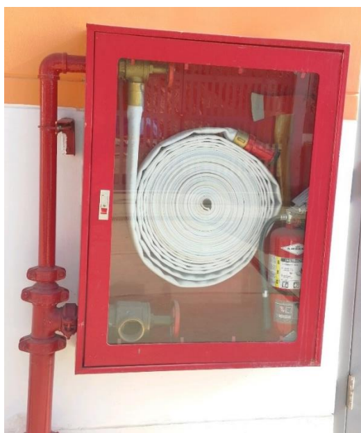
Figura N°16 Conexión de manguera sistema tipo III
