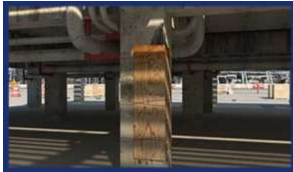
Gráfica 63. Encofrado del elemento a reparar
