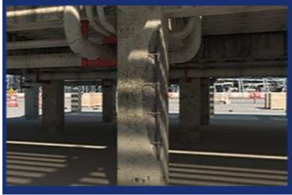
Gráfica 62. Remoción del concreto afectado
