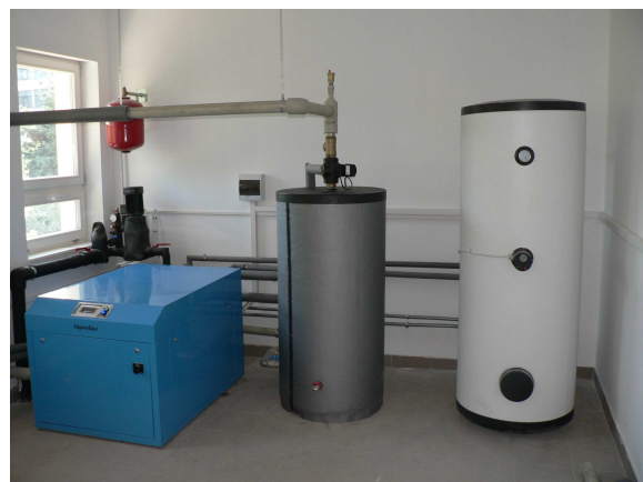
2. ábra. A hőszivattyú, hmv és fűtési puffertartály elhelyezése az intézmény hőközpontjában
