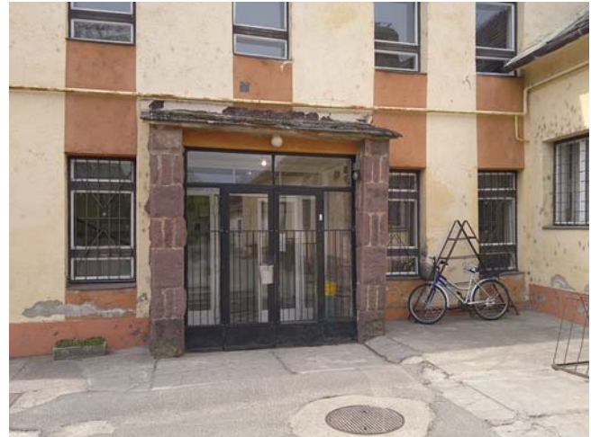
1. kép. Az épület főbejárati része korszerűsítés előtt
